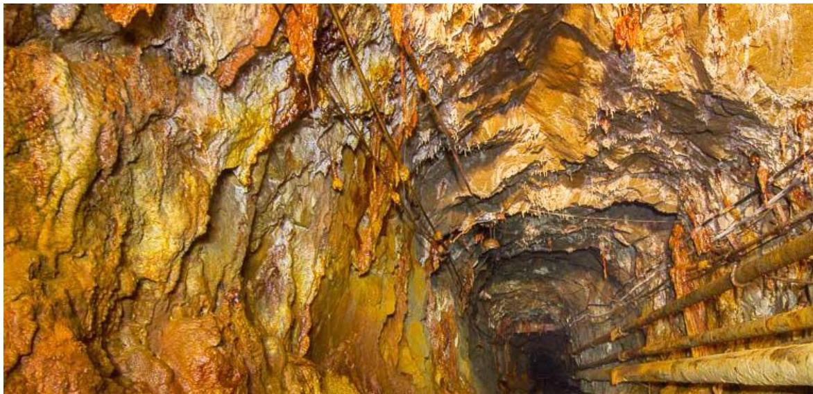
Рисунок 10 – Минералообразование на стенах горных выработок [6, с изменениями]
