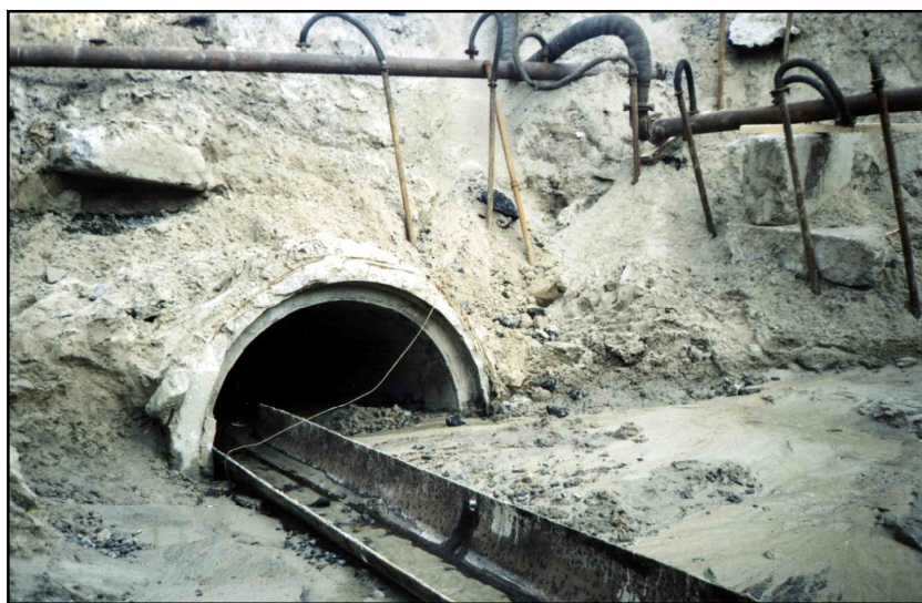
Рисунок 1.12 – Развитие суффозионного процесса по трассе коллектора дождевых вод, ул Хатаевича (сентябрь 2003 г.).
