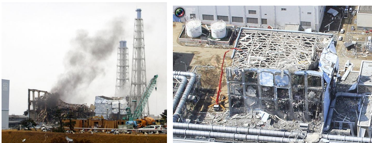
Рисунок 12 – Разрушения на Фукусима-1
