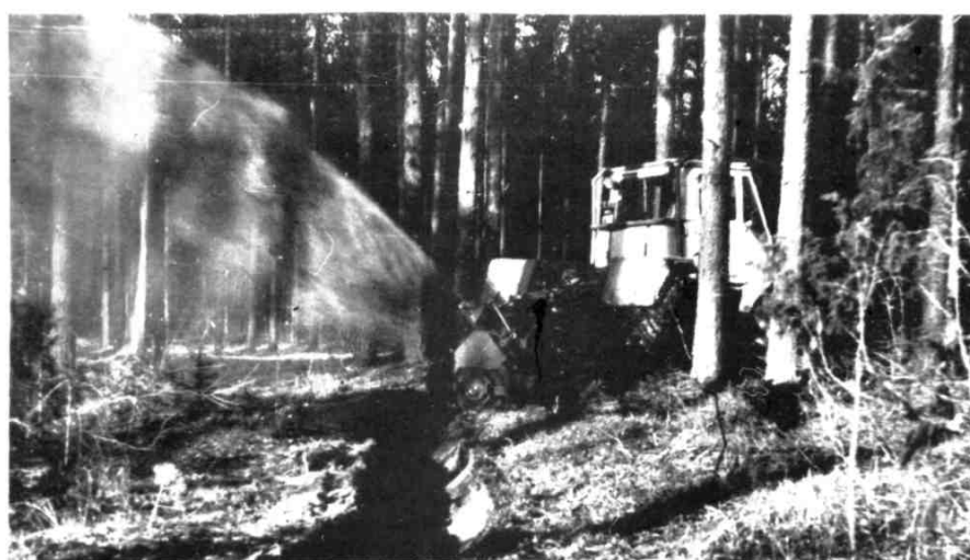
Рисунок 5.10 – Прокладка минерализованной полосы грунтометательной машиной
