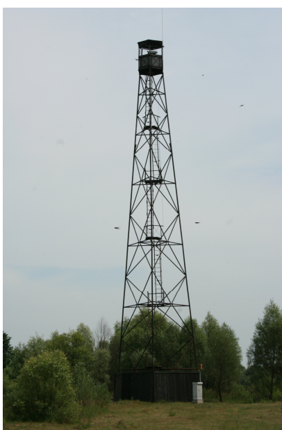
Рисунок 3.2 – Пожарная наблюдательная вышка ПНВ-35
